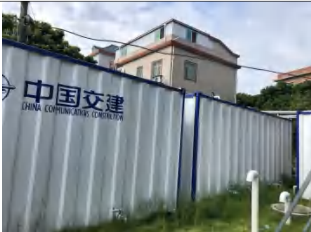
一体化处理设施
