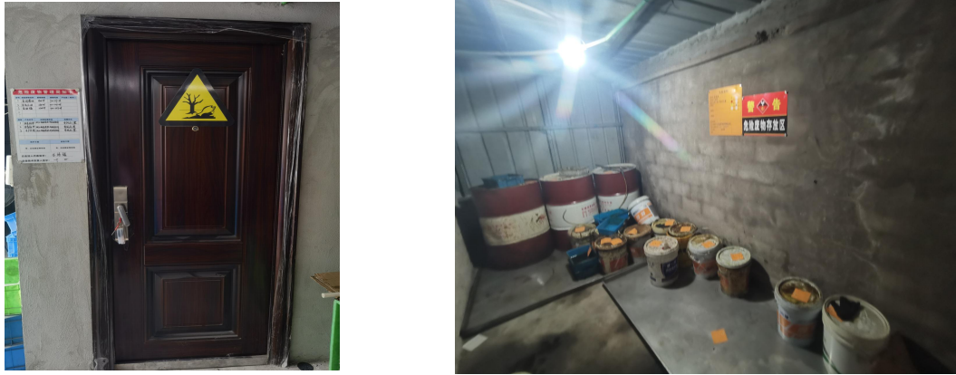
图 3-2 危废仓库现场照片
